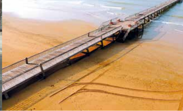
Estacade St Jean de Monts - 85
